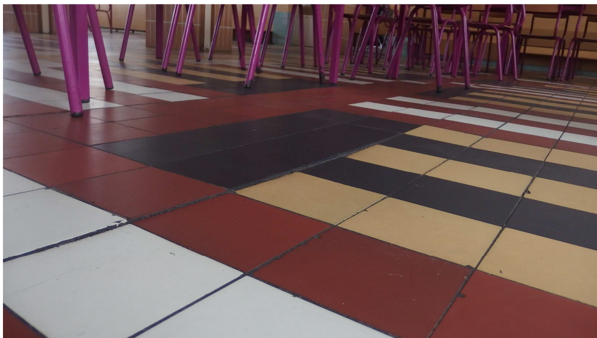
Foto č.3 – výškový rozdíl dlažby ve spáře
