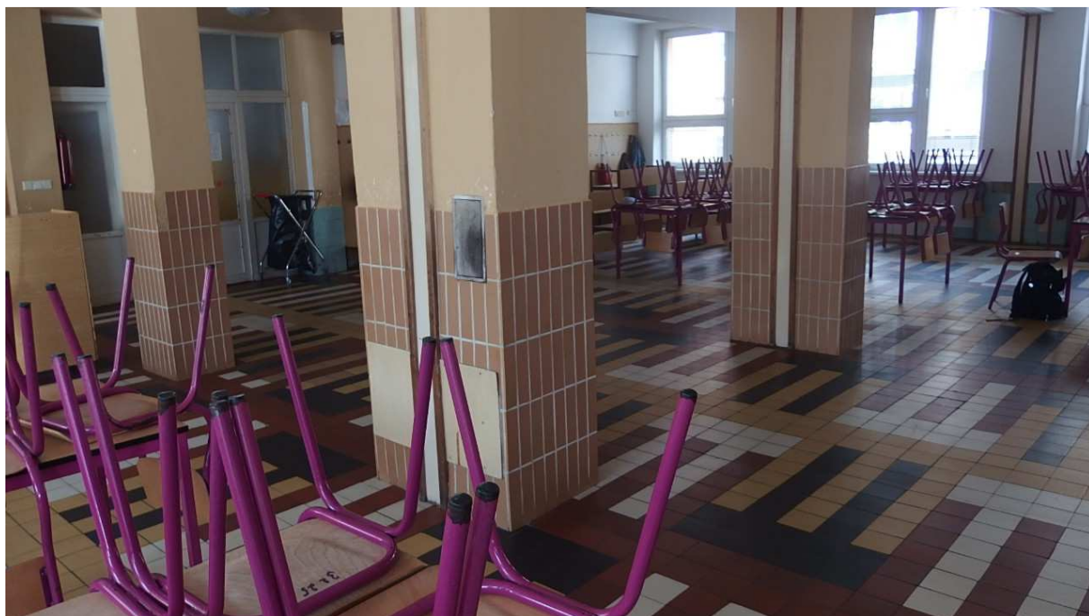
Foto č.6 – pohled na objektovou dilataci – v podlaze není objektová dilatace respektována!
