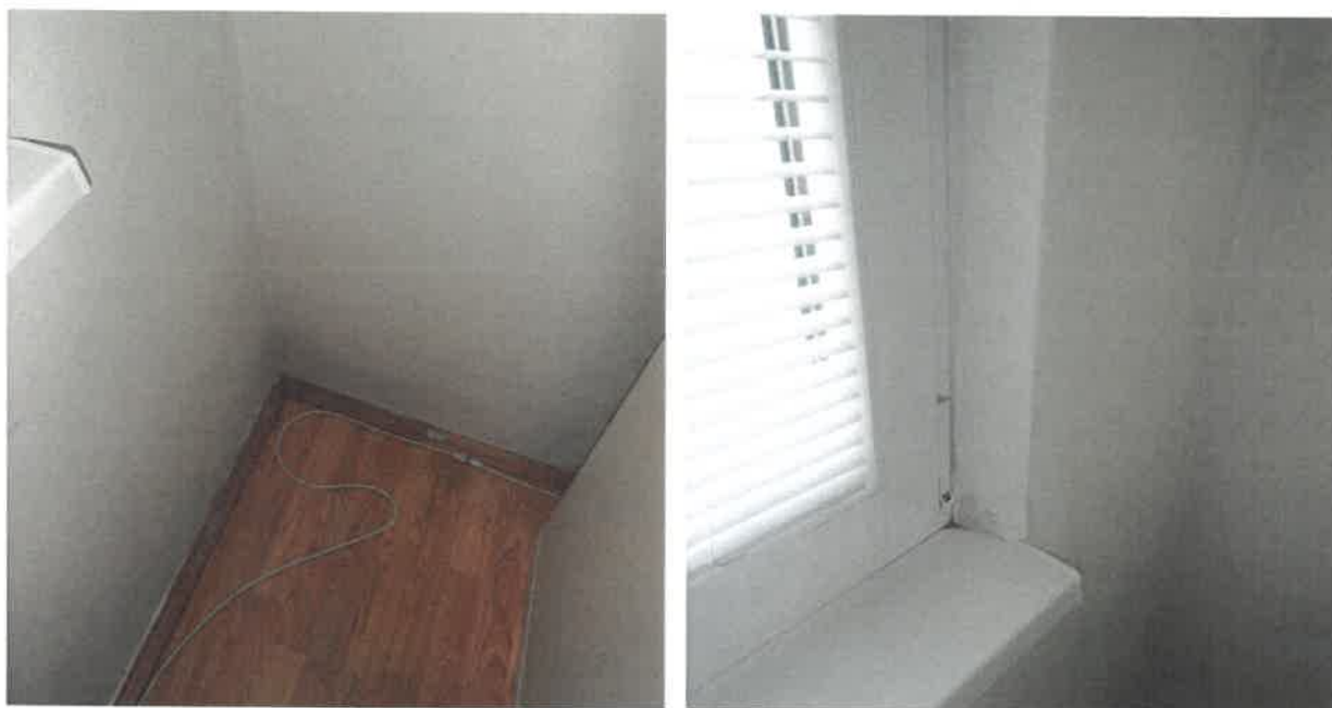
Foto č.1 a 2 - Prochlazené kouty a okenné ostění narušené působením zkondenzované vlhkosti, průběžně aktivně ošetřované proti plísní.
