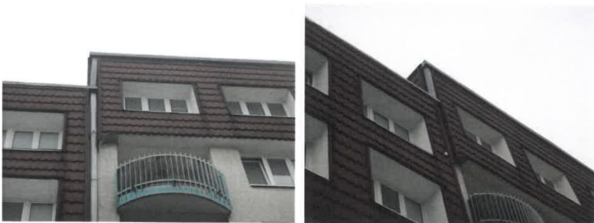
Foto č.5 a 6 - Dilatace mezi výškově posunutými mansardami se střešním svodem.
