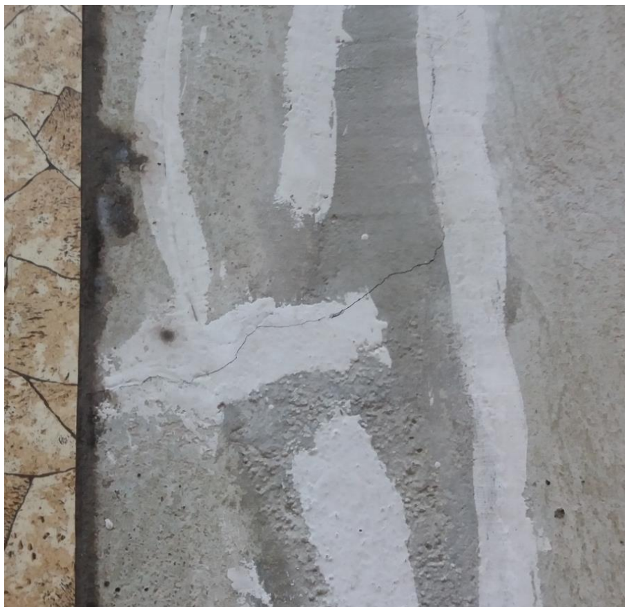
Obr. 4 Trhliny u horního povrchu hrubé podlahy
