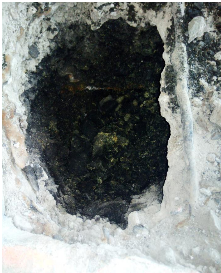
Obr. 6 Podloží podlahy na terénu – hlušina po odebrání vzorků
