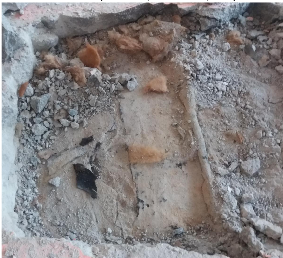
Obr. 5 Sonda po odstranění horní vrstvy cem. potěru
