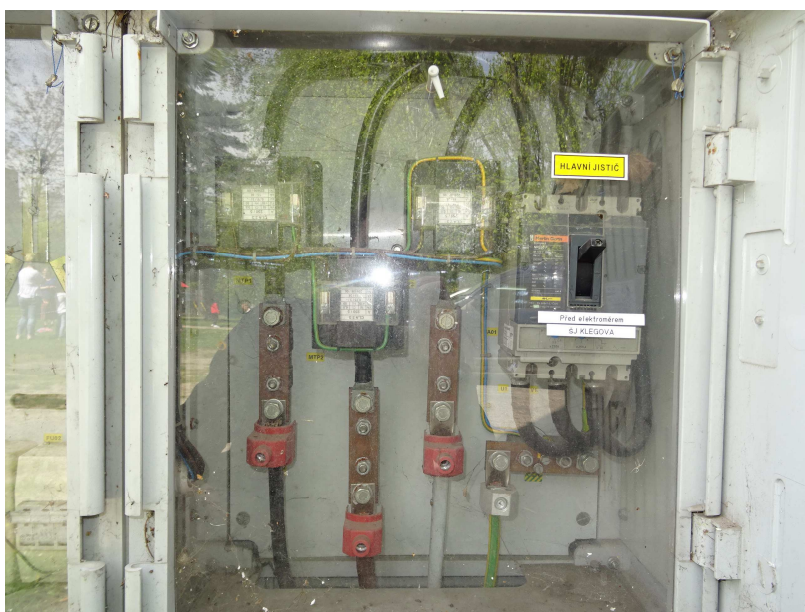
Rozváděč RE s hlavním jističem
