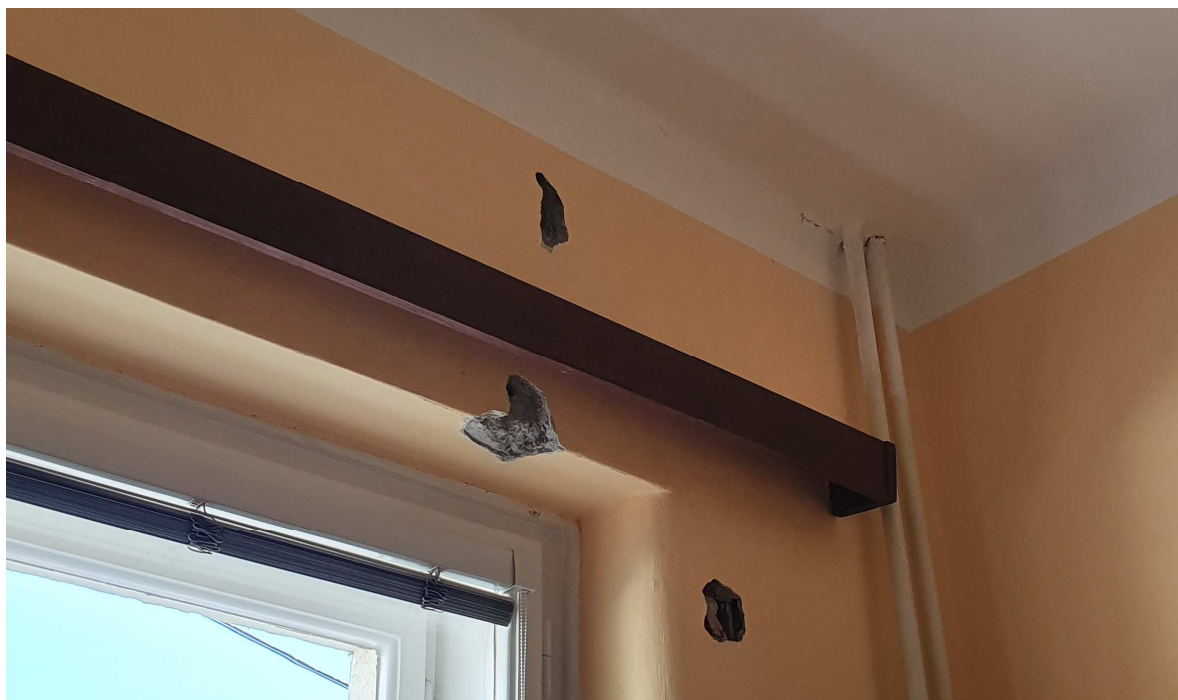
Foto č. 1 - 3: sonda NV 1 (1. NP) – nadokenní překlad
