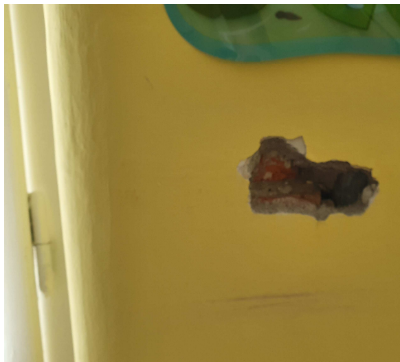
Foto č. 11 - 12: sonda NS 2/1 (2. NP) – ostění okna
