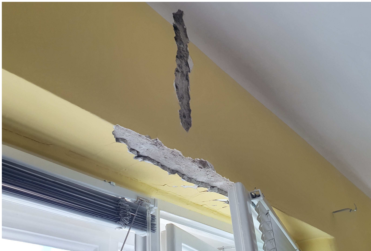
Foto č. 8 - 10: sonda NV 2 (2. NP) – nadokenní překlad
