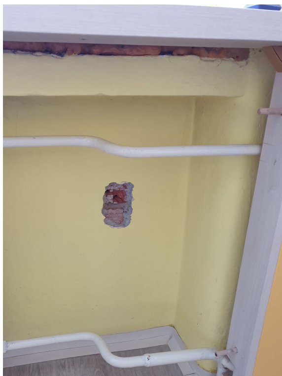
Foto č. 13 - 14: sonda NS 2/2 (2. NP) – parapetní zdivo
