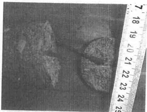
Pohled na podkladní beton vyztužený sítí tloušťky 55 mm.
