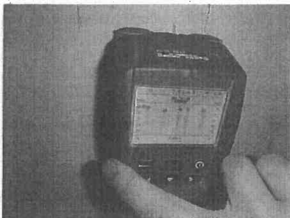
Pohled na detekci výztuže radarem HILTI PS 50.
