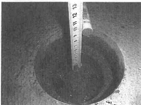
Pohled na jádrové vrtání do podlahy v 1.NP:
