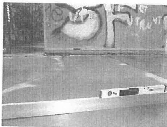
Pohled na měření příčného spádu střešní konstrukce.
