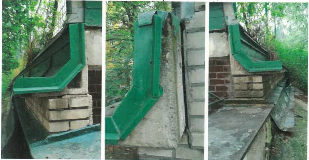
1.17 Trhlina a spára podél betonového žlabu a oplechování na něm
