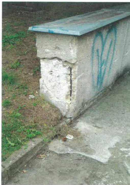
1.09 Val podél parkovacího objektu, mezera mezi stavbou a valem
