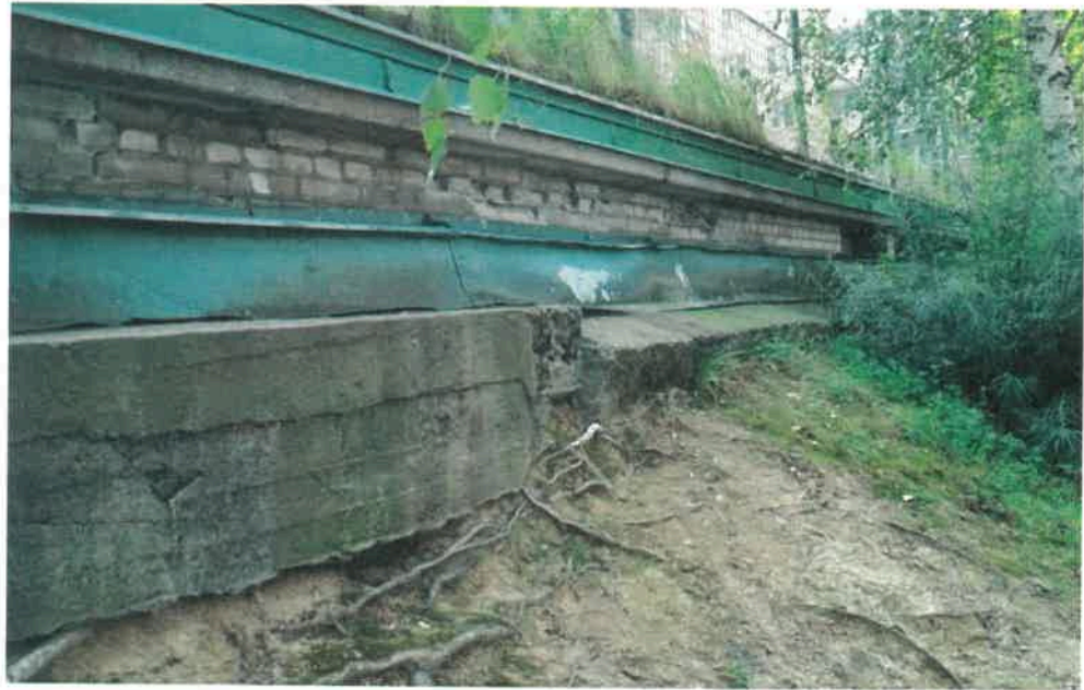
1.17 Trhlina a spára podél betonového žlabu a oplechování na něm
