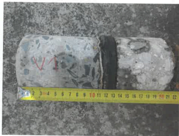
90 mm beton, který byl proveden dodatečně.
