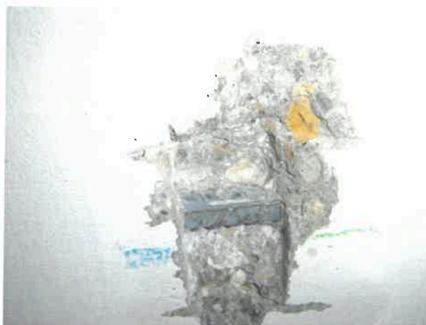
Výztuž stropního panelu s žebírky odpovídající výztuži druhu V. Povrch prutu byl bez koroze.
