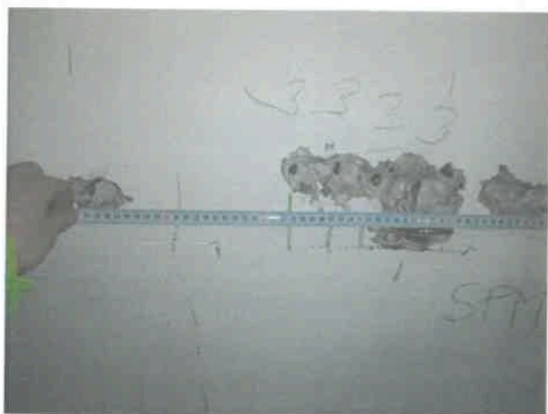
Pohled na část sondy na spodním líci kratšího deskového průvlaku.
