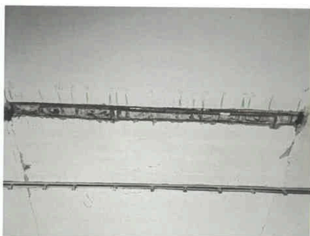
Sonda na spodním líci delšího deskového průvlaku.
