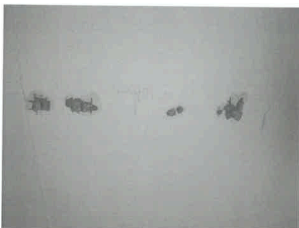
Sondy na spodním líci stropního panelu.
