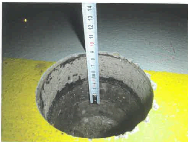
Vývrt do podlahy v 1.NP.
