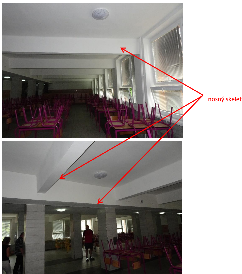
Obr. č. 16 Pohled na nosnou konstrukci školní jídelny
