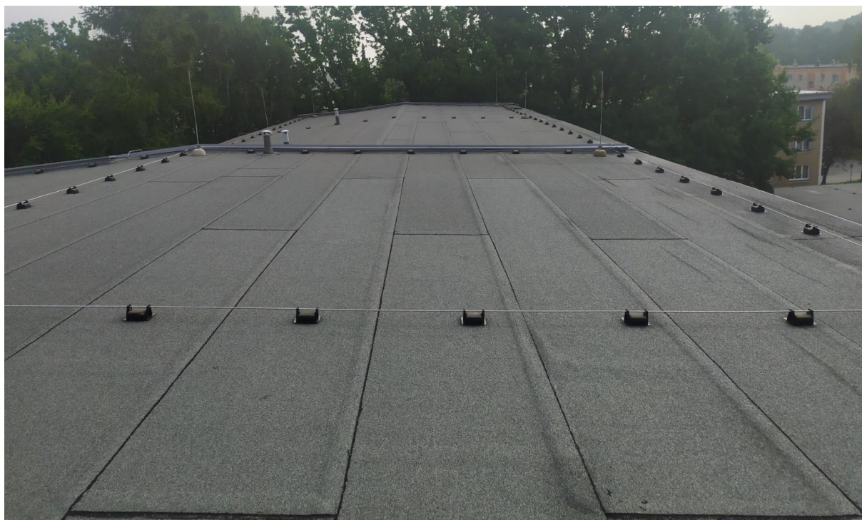
Obr. č. 2 Střecha objektu Kosmonautů 15
