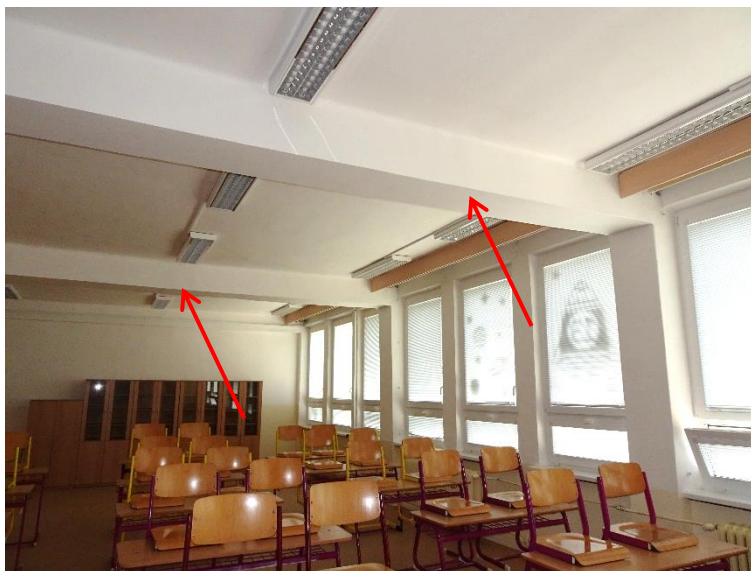
Obr. č. 10 Pohled na příčné rámy (ZŠ Kosmonautů 13)
