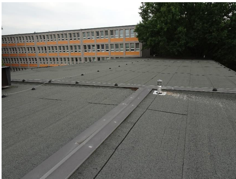
Obr. č. 17 Pohled na střešní plášť
