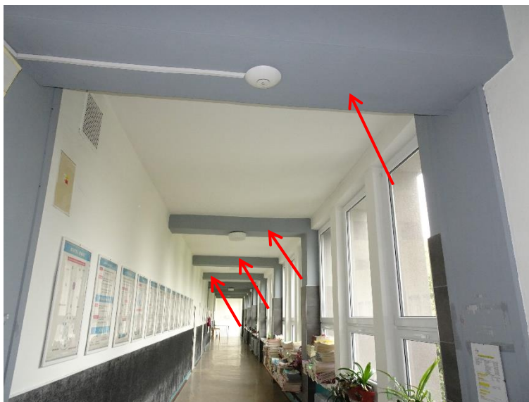
Obr. č. 8 Pohled na příčné rámy (ZŠ Kosmonautů 15)
