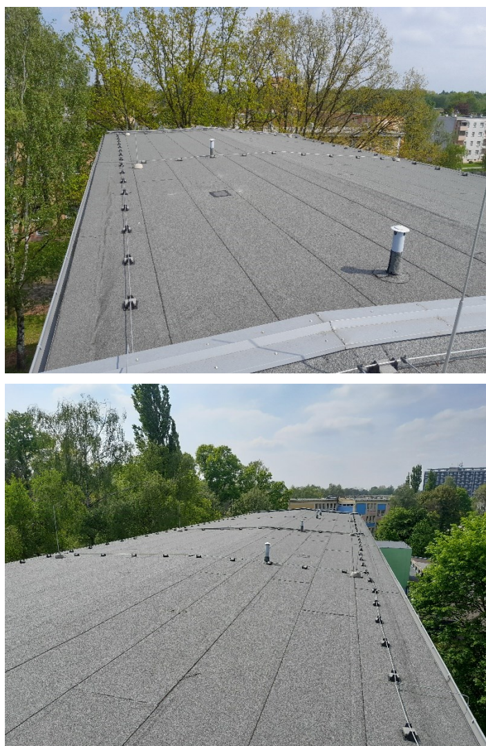
Obr.8 Pohledy na kontrolovaný střešní plášť ZŠ a MŠ Kosmonautů 2217/15
