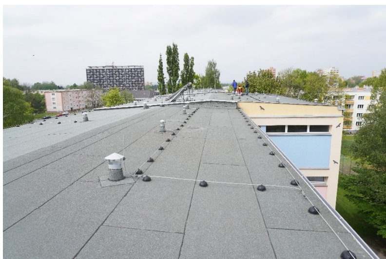
Obr.5 Pohledy na kontrolovaný střešní plášť ZŠ a MŠ Kosmonautů 2218/13
