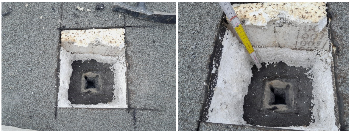
Obr.4 Realizovaná sonda do střešního pláště S1 – ilustrační pohled
