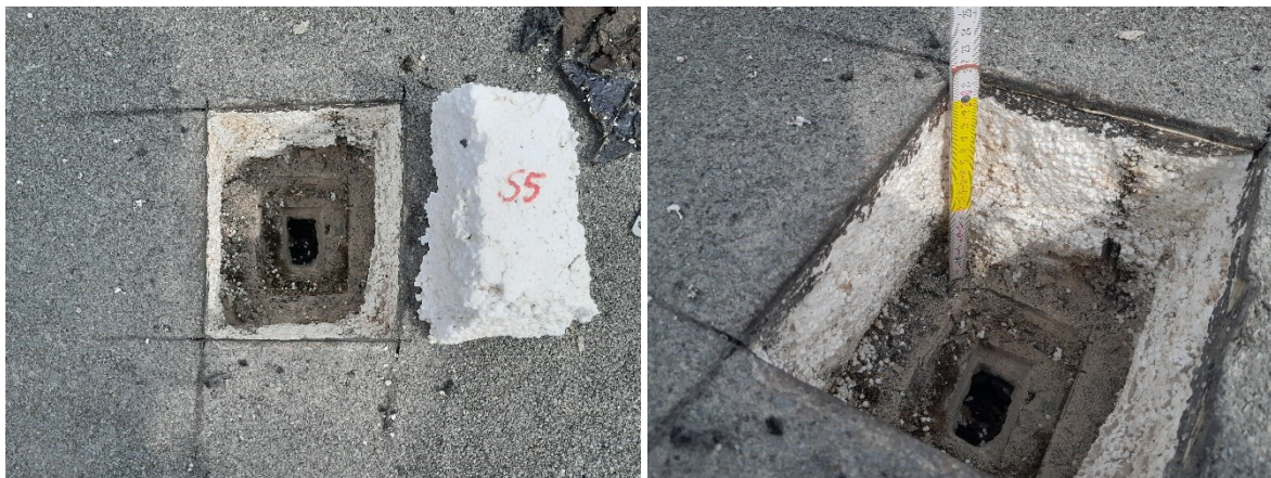
Obr.7 Realizovaná sonda do střešního pláště S5 – ilustrační pohled
