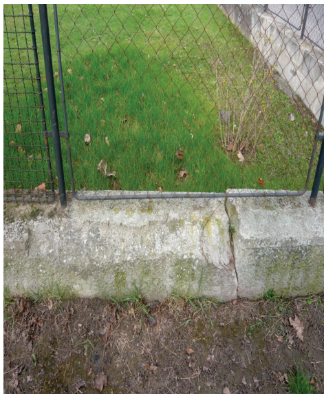
Úsek č. II, pole č. 2 - prasklina v betonovém soklu – ozn. „A“
