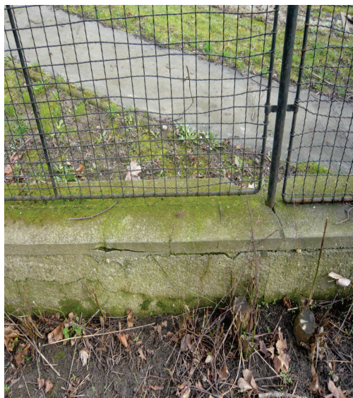
Úsek č. III, pole 8 až 9 - prasklina mezi zhlavím a betonovým soklem – ozn. „B“
